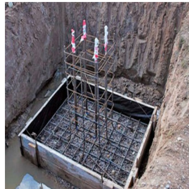
рис. 13. армирование фундамента (пример)
