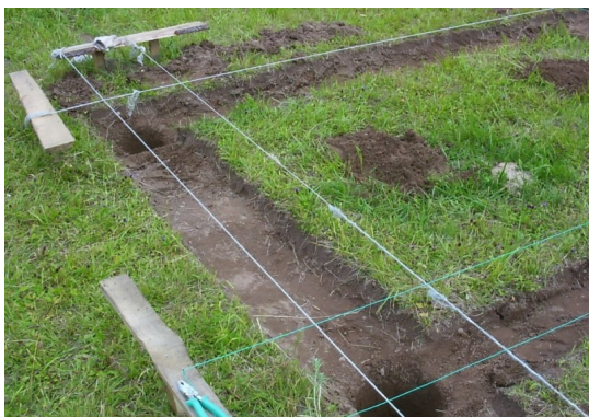
рис. 5. - осёвка сооружения (пример)
