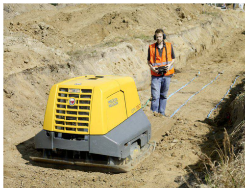
рис. 9. уплотнение основания (пример)
