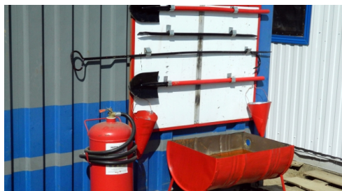
рис. 47. - пожарный щит в монтажном городке (пример)
