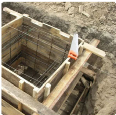
рис. 12. устройство опалубки (пример)
