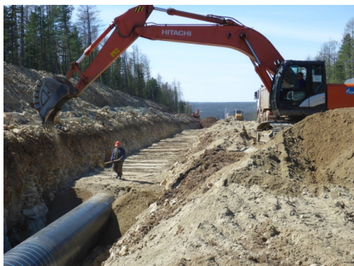
рис. 10.обратная засыпка (пример)
